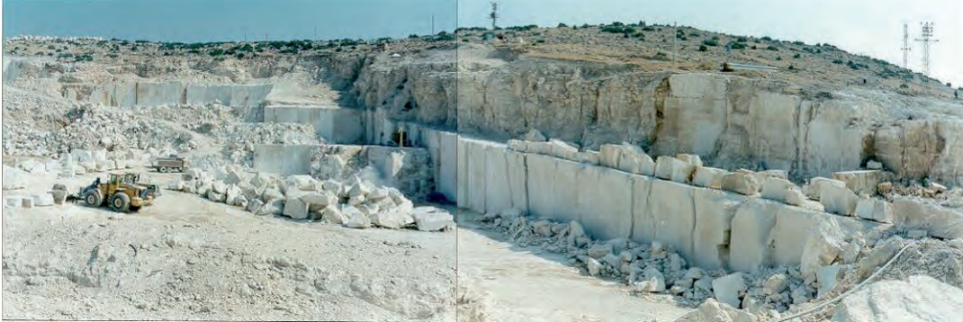
Şekil 5.7: Alimoğlu traverten ocağında yüzeyden yaklaşık 18 - 20 m. derinde üretim yapılan ekonomik traverten damarının bir tabaka halinde yüzeye paralel gidişinin görünümü. Bu tabaka biraz daha kompakt görünümde olup, tatlı bir eğimle güneye doğru uzanmaktadır. Tabakanın üzerindeki ortalama 18 - 20 m. lik kesim, tüm ocak görüntüsü içinde, tıraşlanıp atılmıştır (Fotoğraf 2000 yılında çekilmiştir).
