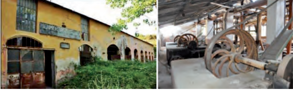
Şekil 2.37: Saraylar beldesinde bulunan 1912 yapımı 8 katraklı eski mermer fabrikası (mermer taş fabrikası).
