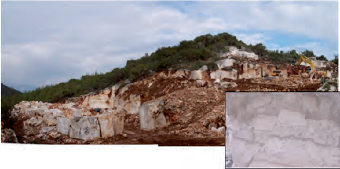
Şekil 1.119: 2006 yılında işletilmeye devam edilen ancak 2013 yılında resifal düzey bittiği için terk edilen Likya bej ocağı ve Likya bej mermeri.
