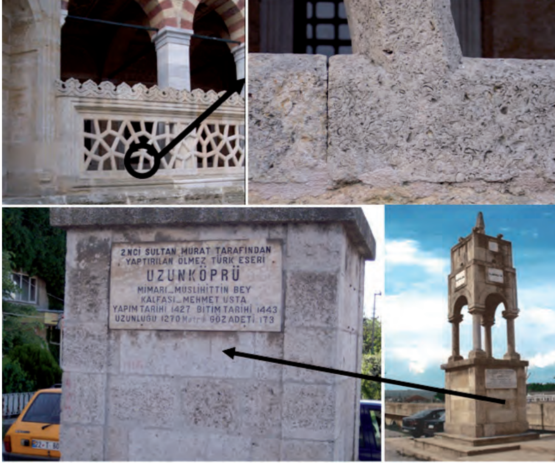
Şekil 1.191: Üstte Edirne'de Mimar Sinan tarafından yapılan Selimiye camisinde kullanılan Maktralı kireçtaşları, yanda ise Edirne, Uzunköprü ilçesinde 11 Aralık 1908 de açılışı yapılan Hürriyet anıtı.
