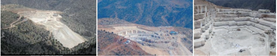
Şekil 5.89: Aksazak traverten bölgesinde yörenin en büyük ocaklarından biri olan Polmer firmasına ait Göksu light traverten ocağının çeşitli görüntüleri.
