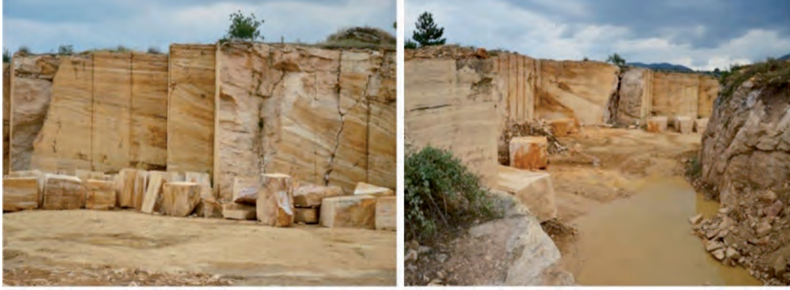
Şekil 5.99: Antea mermer firmasına ait Eskipazar sarı traverten ocağı.
