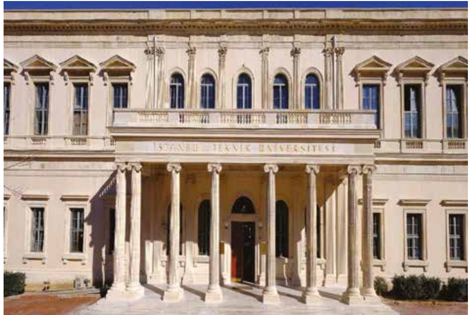
İTÜ Taşköprü Mimarlık Fakültesinin Değişik Yöntemler Uygulanarak Temizlenmiş Görünümü
