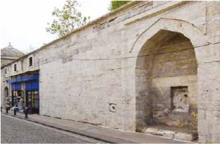
Süleymaniye Külliyesi duvarlarında kullanılan Bakırköy Küfeki taşları.
